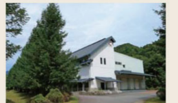
パイロゲン工場
