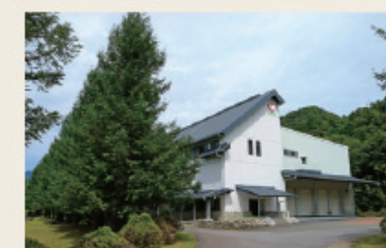
パイロゲン工場
